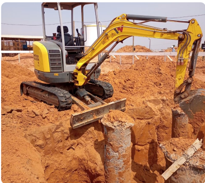
Wacker Neuson escavação de fundação
