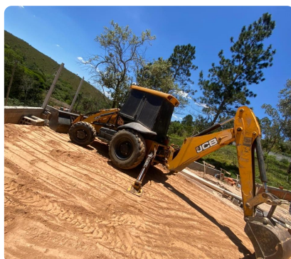
JCB Retroescavadeira terraplanagem e fundação
