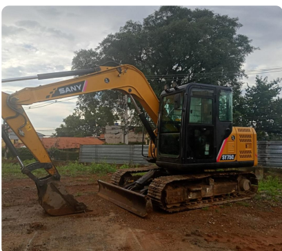
SANY SY75C terraplanagem em canteiro
