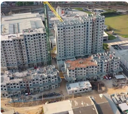
Escavação e aterro – obra predial
