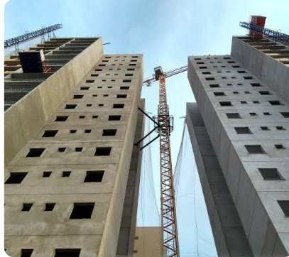
Torres – estrutura em andamento
